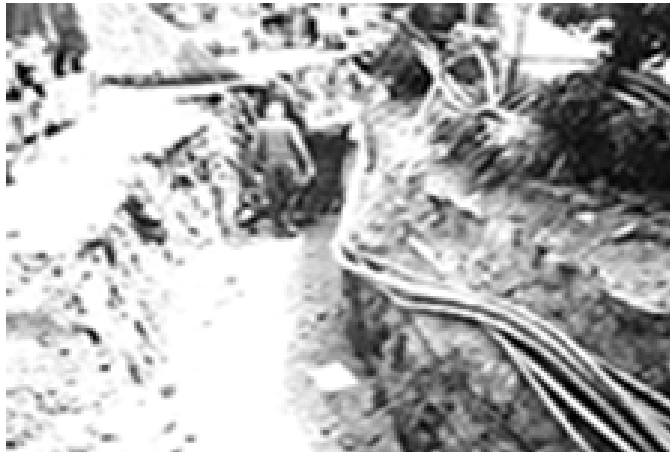
Gambar II.6 Penggelaran kabel serat optik jenis Kabel Tanah Tanam Langsung
