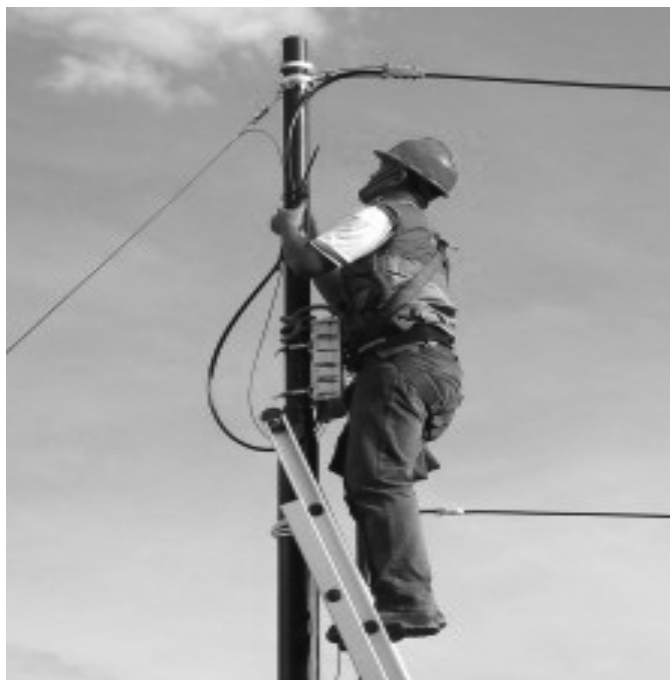
Gambar 3.1 Perhatikan saat akan melakukan instalasi kabel udara, apakah terdapat jaringan listrik.
