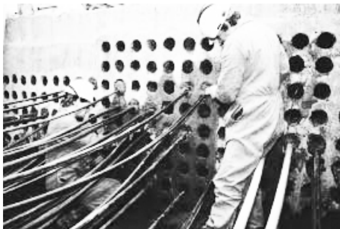
Gambar II.7 Penggelaran kabel Serat Optik jenis kabel Duct
