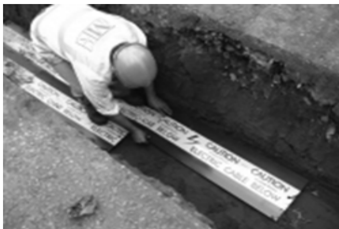
Gambar 3.20 Sebelum di urug tanah jalur kabel diberi tanda dengan Capstone
