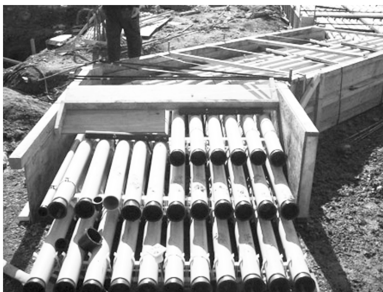
Gambar 3.22 Pipa pelindung kabel dicor dengan beton 1:2:3
