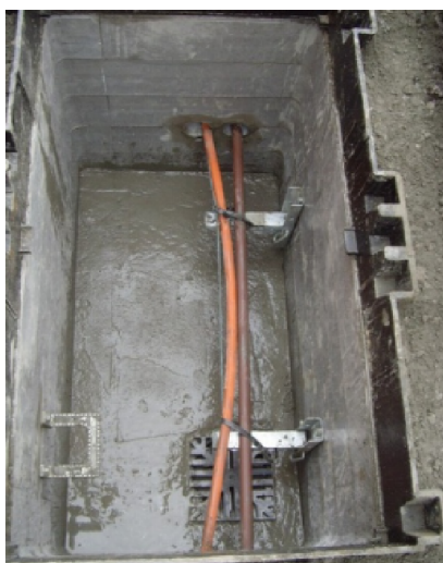
Gambar 3.26 Contoh Manhole dengan 2 pipa Duct
