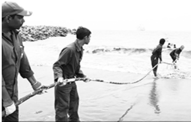
Gambar II.8 Penggelaran Kabel Serat Optik jenis Kabel Laut / Sungai
